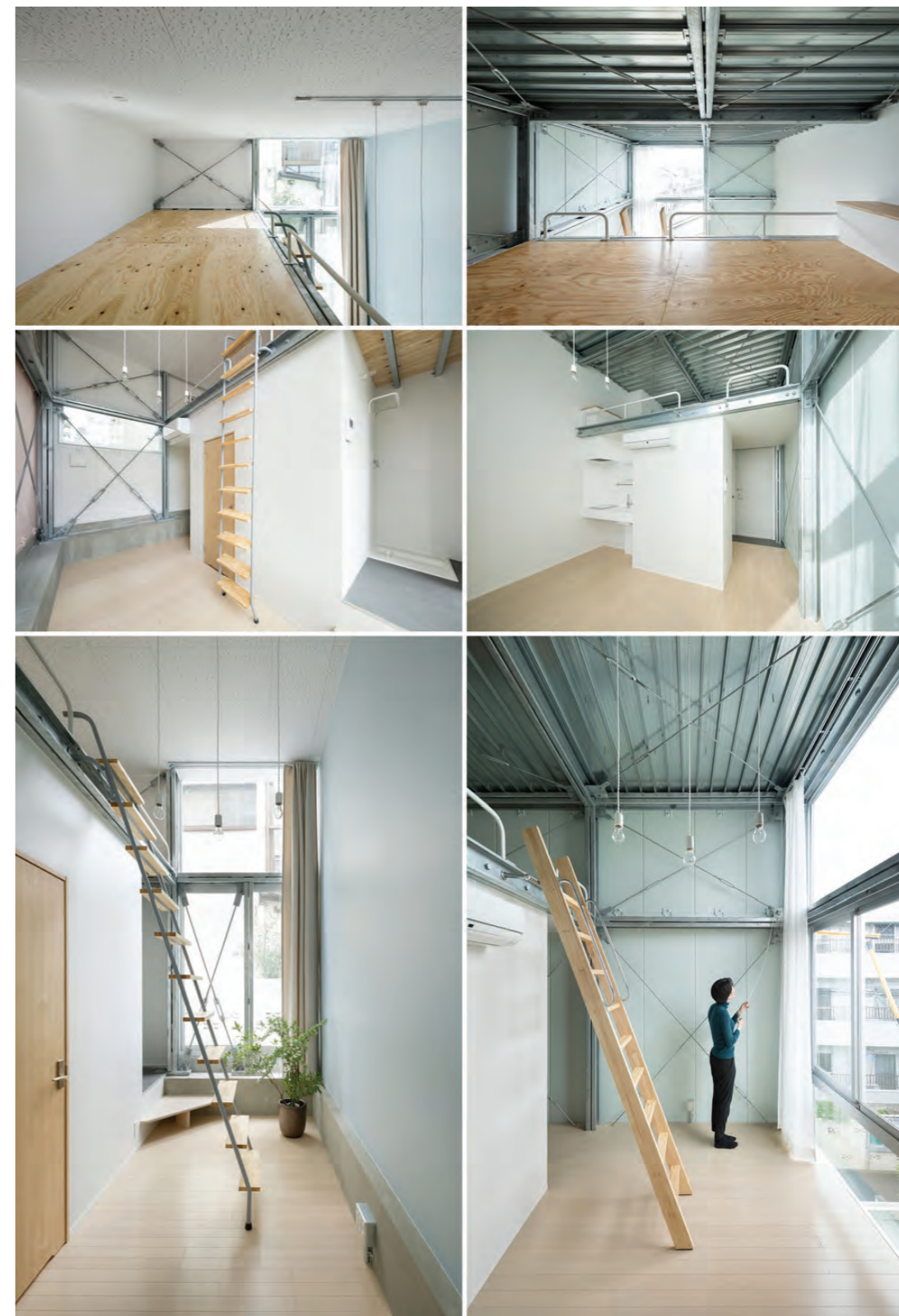
特殊軽量鉄骨造を用い、18㎡の床にロフト床を8㎡足して大きな気積と窓を持つワンルームを実現
